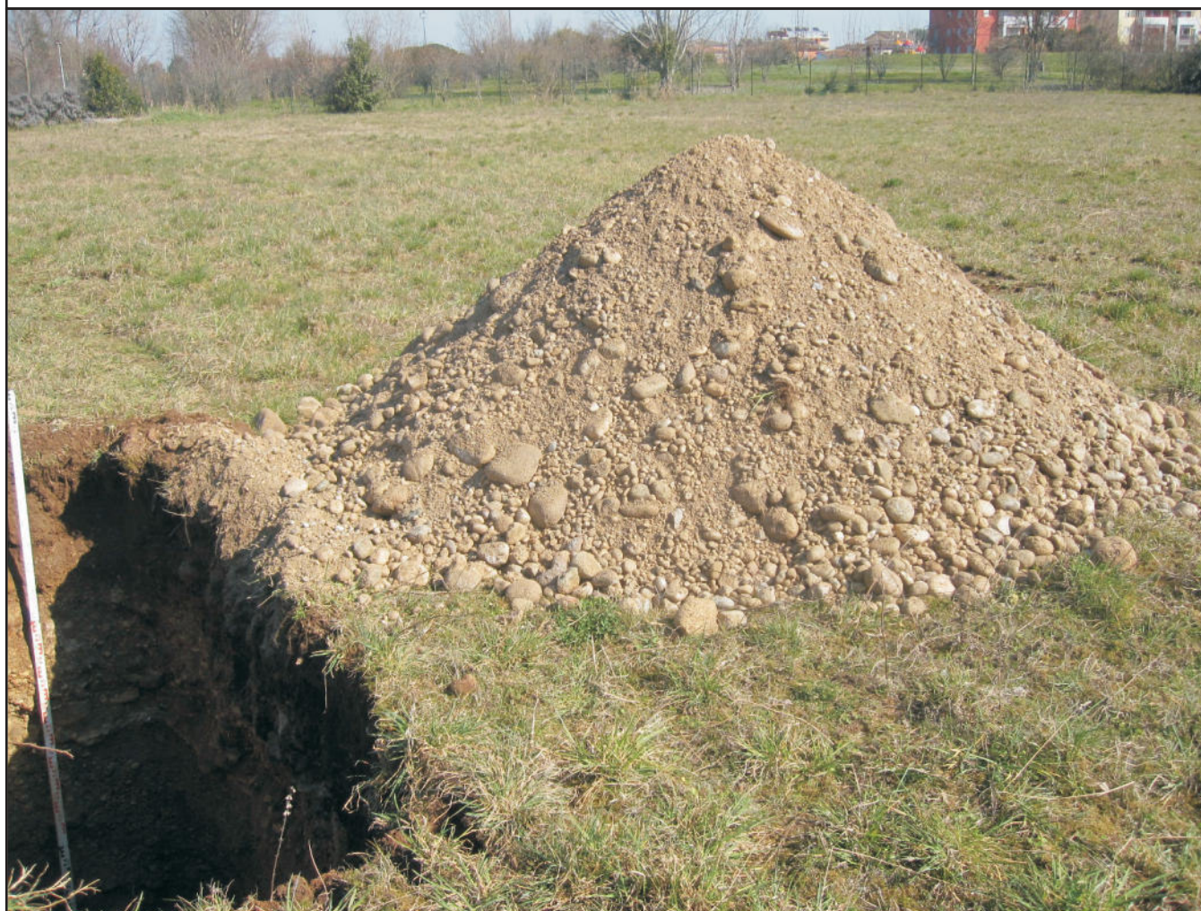
Cumulo dei depositi ghiaiosi con sabbia e ciottoli rinvenuti durante l'esecuzione della trincea esplorativa n.1
